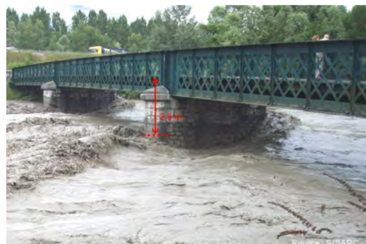
L'Arc en crue au niveau du pont de l'Arc (mai 2008)
