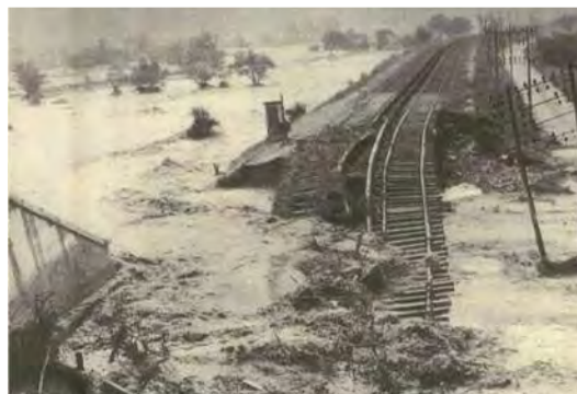
Destruction de la voie ferrée Chambéry-Modane (crue juin 1957)
