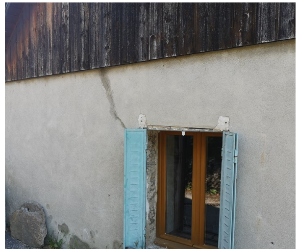
Figure V.8: Fissure liée à un tassement différentiel
