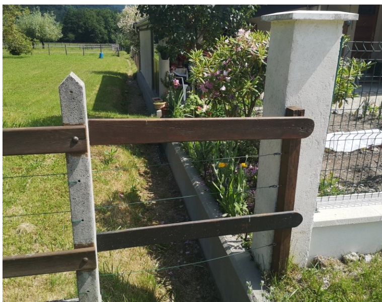
Figure V.27: Passage du fossé au niveau du lieu-dit Le Perrier.
