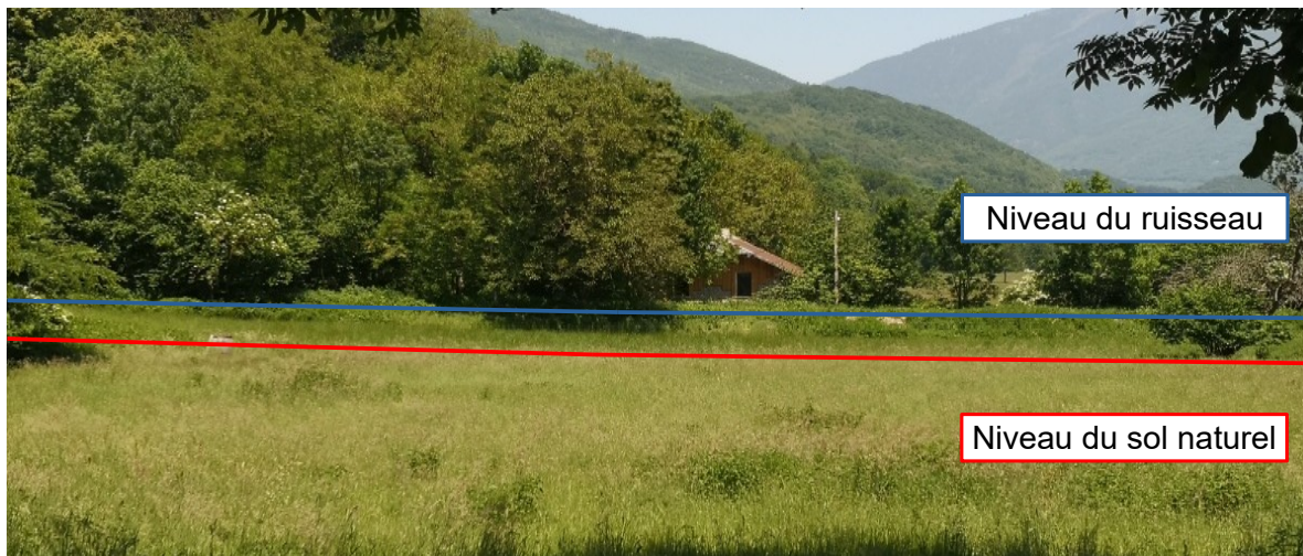
Figure V.25: Passage du lit du ruisseau du Chevillard surélevé par rapport au premier plancher du bâti
