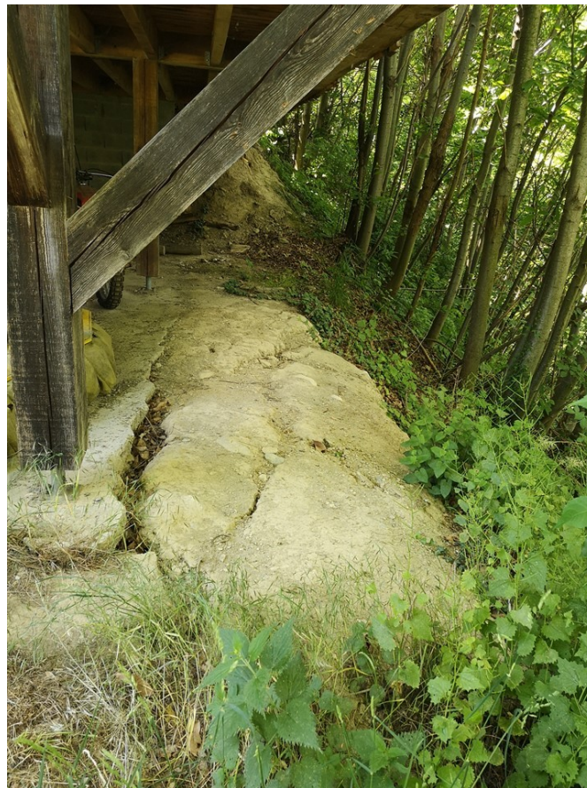
Figure V.9: Signes d'instabilités du sol
