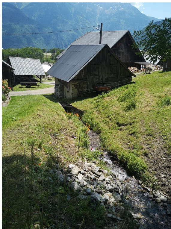
Figure V.22: Vue du ruisseau en amont du hameau des Champs, entrée de la buse traversant le lieu-dit, l'entrée est protégée par une grille.
