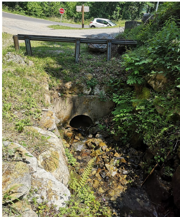
Figure V.24: Entrée de buse du ruisseau du Chevillard, au lieu-dit Chef-lieu
