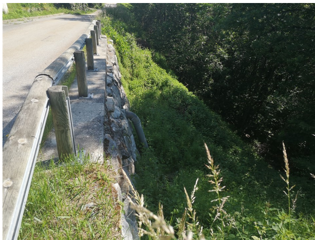
Figure V.6: Mur de Soutènement au niveau du hameau des Plattières
