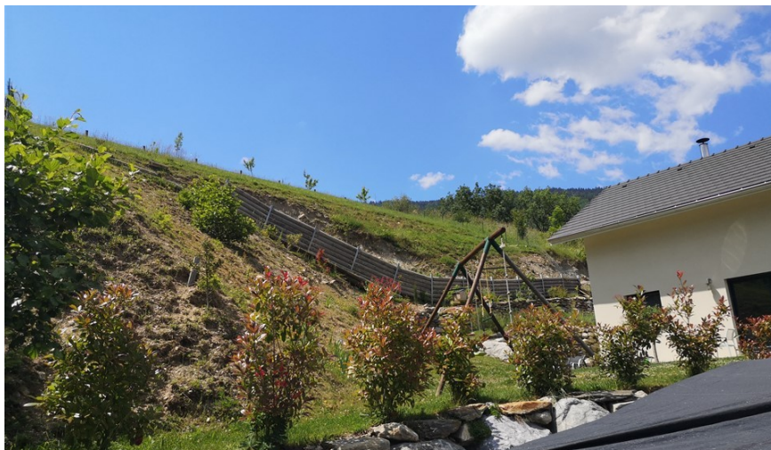
Figure V.10 Protection d'un talus instable à l'aide d'un mur de soutènement
