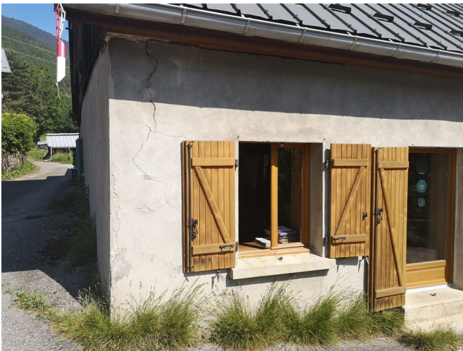
Figure V.7: Fissures liées à un tassement différentiel
