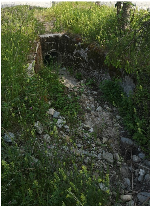
Figure V.21: Buse du ruisseau des Lozières à l'entrée du hameau des Champs
