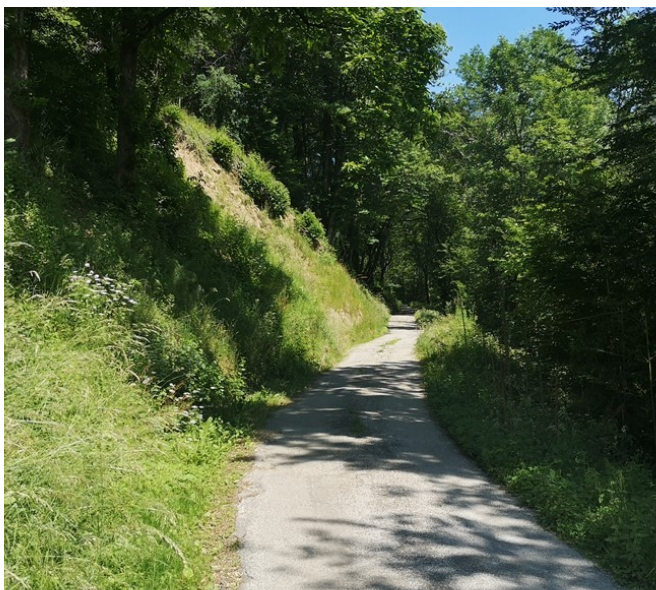
Figure V.11: Niche d'arrachement et signes de déformation de la route
