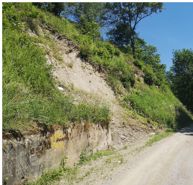
Figure V.12: Niche d'arrachement au niveau de la route reliant le Verney et le Jardin
